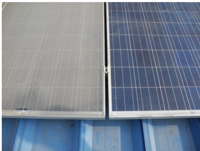
图1：组件灰尘遮挡现象
