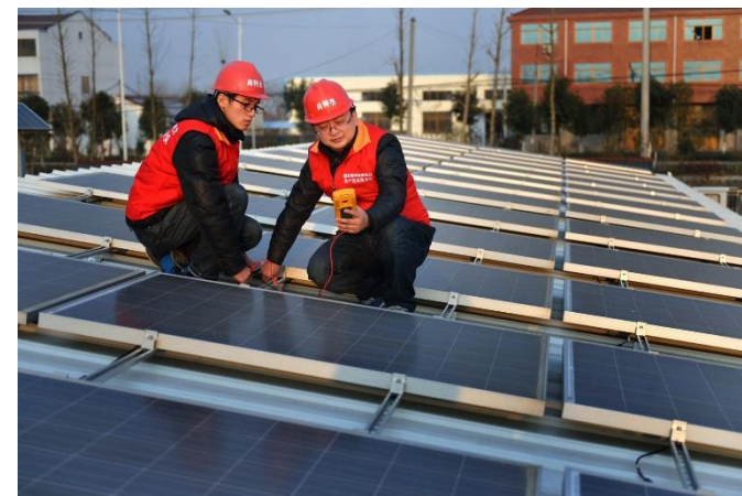
光伏晶片检修
